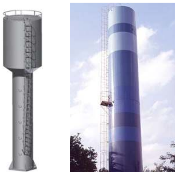
Fig. 18 - Reservatório d' água
