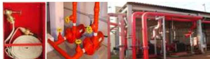
Fig. 1 - Detalhes – Sistema de hidrantes
